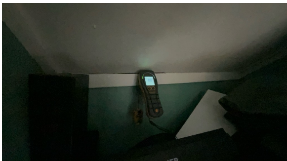
Ingen unormale fuktindikasjoner ved misfarge på befaringdagen.
