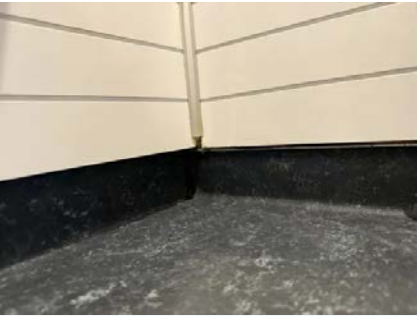
Utførelse av baderomsplater er ikke i samsvar med produsentens anvisninger.
