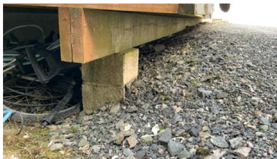
Kontroll av fundament. Kommende lokale utbedringer kan ikke utelukkes på sikt.
