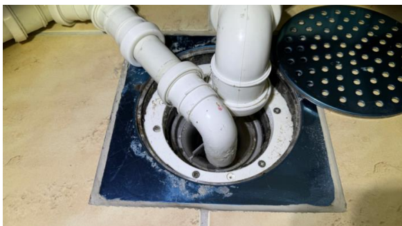
Kontroll av sluk.
