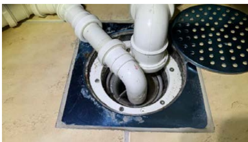
Kontroll av sluk.
