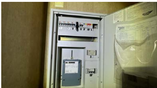
Kontroll av el-skap og kursfortegnelse.
