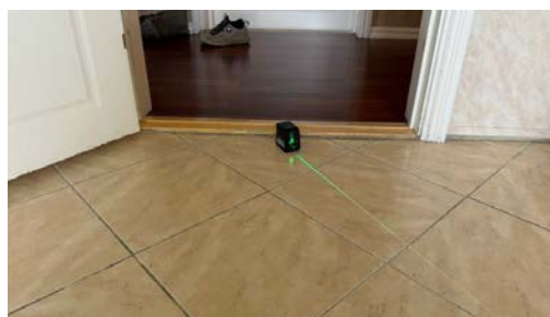
Kontroll av fallforhold.
