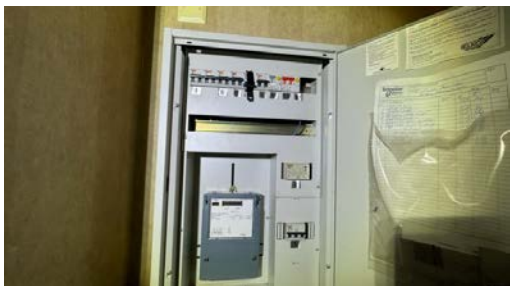
Kontroll av el-skap og kursfortegnelse.
