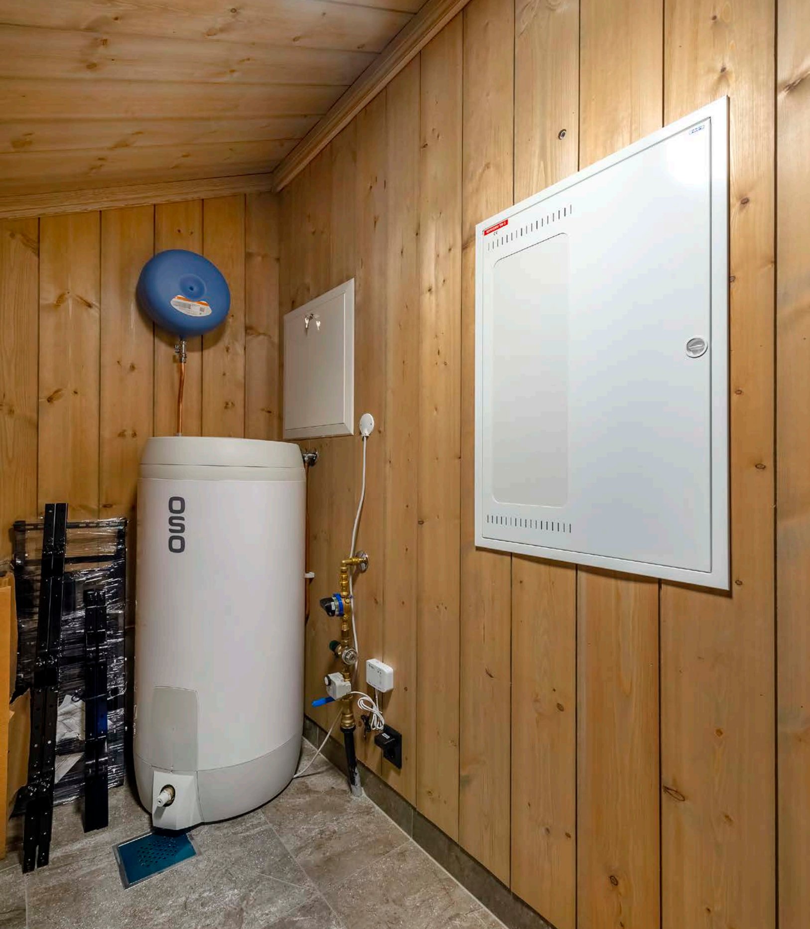
Bod/teknisk rom (1. etasje)
