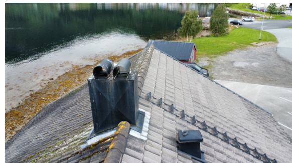
Oversikt takstige, luftehatt og pipe
