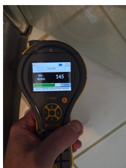
Fuktsøk er utført på gulv ved dusj. Ingen forhøyde fuktavvik er målt
