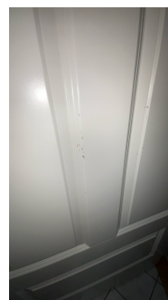
Noe mindre skader i overflater på enkelte dører
