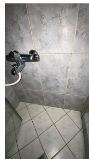
Oversikt fliser på vegg inne i dusjen
