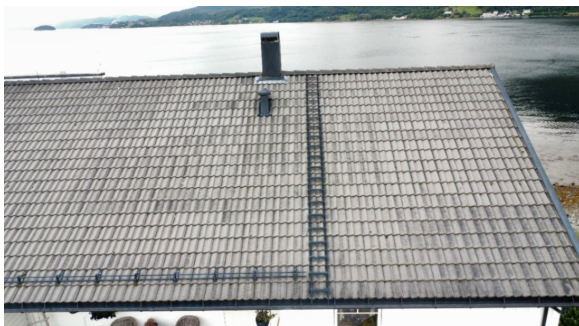
Oversikt takstige og pipe
