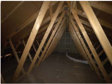
Det er påvist fuktskjolder/misfarging i takkonstruksjonen. Undertak har ingen mansjett/tetting rundt gjennomføringer i undertak
