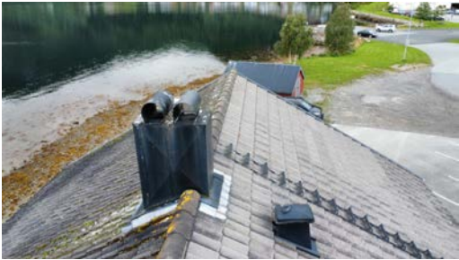
Oversikt takstige, luftehatt og pipe
