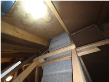
Det er påvist fuktskjolder/misfarging i takkonstruksjonen. Undertak har ingen mansjett/tetting rundt gjennomføringer i undertak
