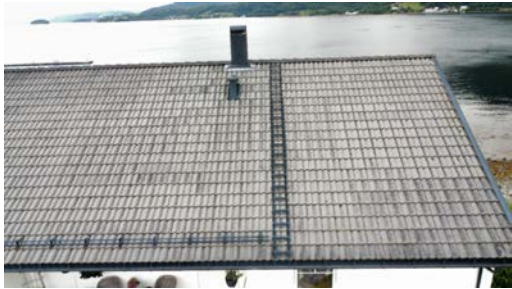
Oversikt takstige og pipe
