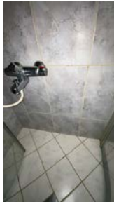
Oversikt fliser på vegg inne i dusjen
