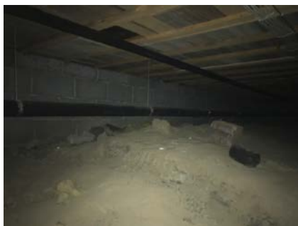
Krypkjeller med tilgang fra luke i vegg ved trapp til fyrrom.
