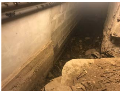
Kryp kjeller med tilgang via dør til terreng.
