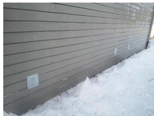
Kappet rør og montert netting/ventil
