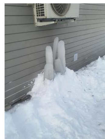
Var en del is under varmepumpe, skal fjerne å sikre bak der 25.feb.
