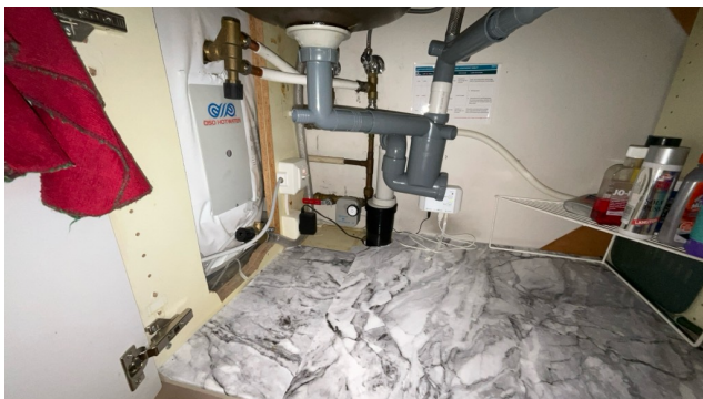
Besiktigelse av røropplegg.
