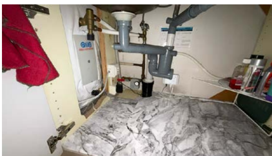
Besiktigelse av røropplegg.
