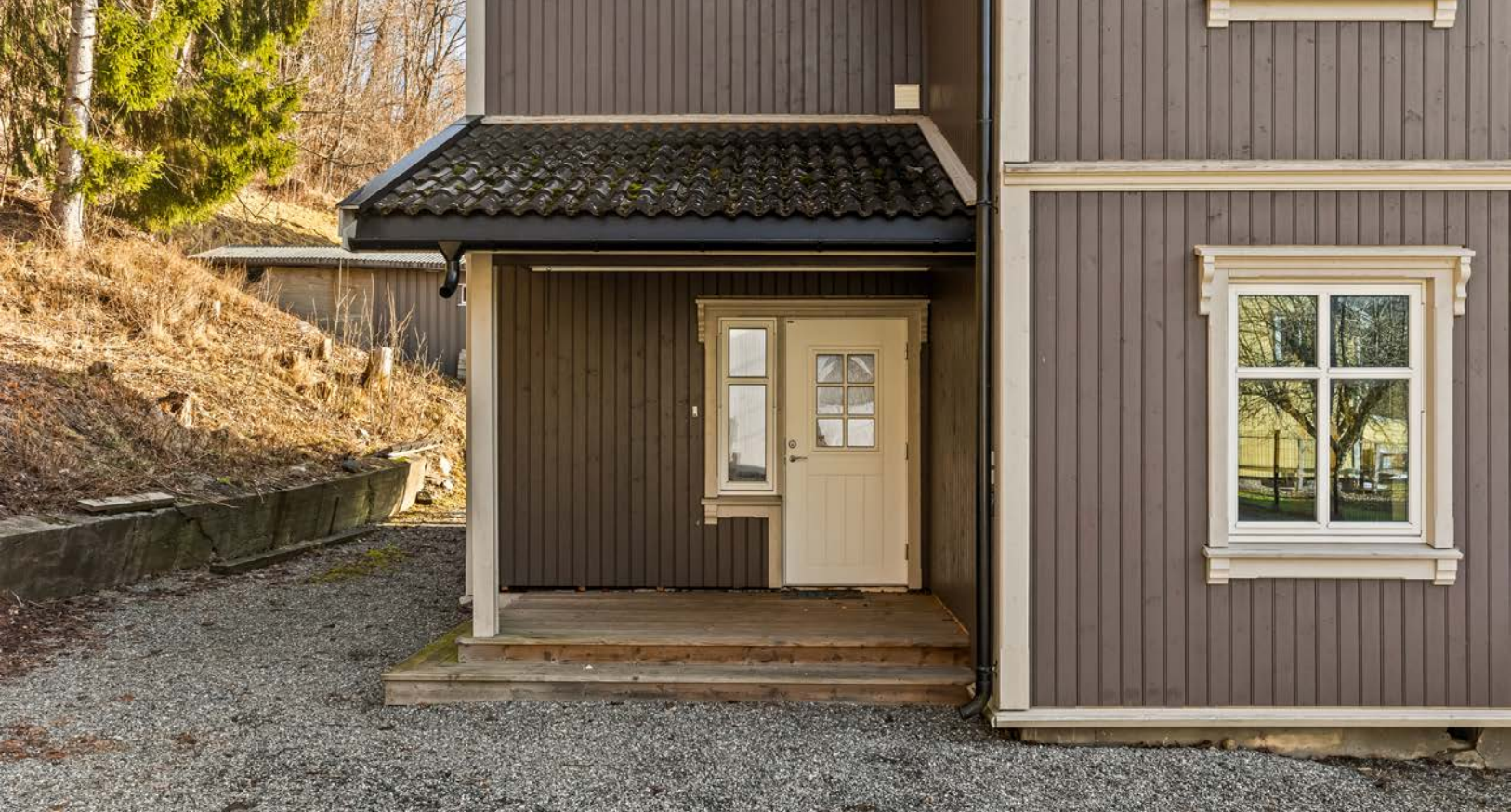
Hyggelig inngangsparti til 1. etasje.
