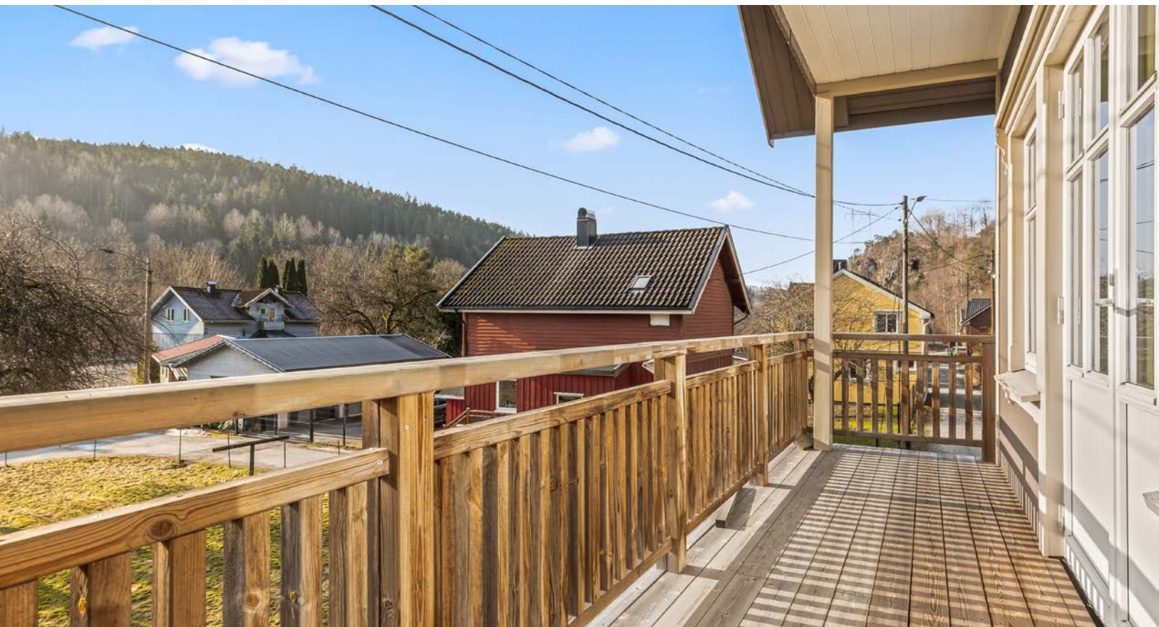
Veranda i 2. etasje
