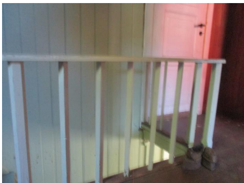
Lav høyde rekkverk.
