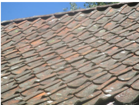
Deler av taktekkingen.
