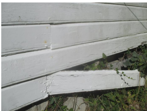
Slitt/skadet kledning.
