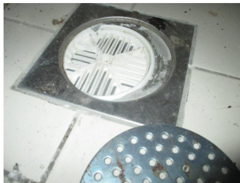
Sluk i dusjhjørne. (rist på sluk sitter fast)
