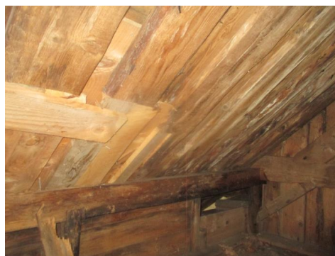
Åsetak med bord som undertak.
