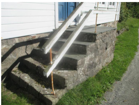
Deler av utvendig trapp.
