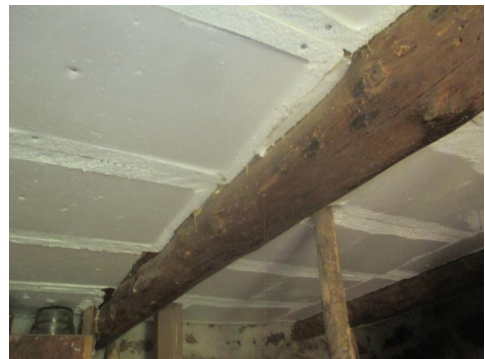
Er blitt isolert med isopor i grovkjeller under ene stuen.
