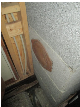
Elementpipe med sotluke i mellom kjøkken og badet.
