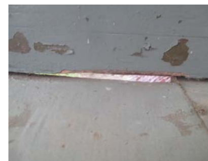
Åpning langs gulvet i ene stuen.
