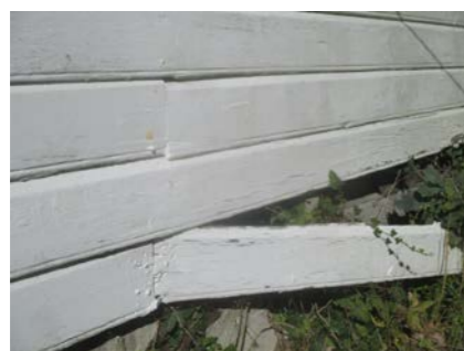
Slitt/skadet kledning.
