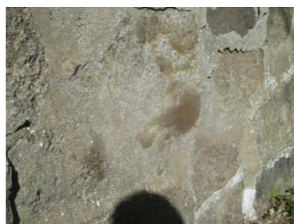
Deler av grunnmur.
