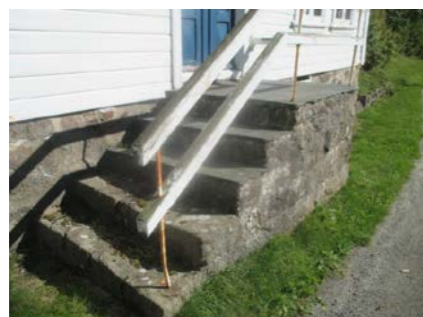
Deler av utvendig trapp.
