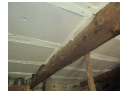
Er blitt isolert med isopor i grovkjeller under ene stuen.
