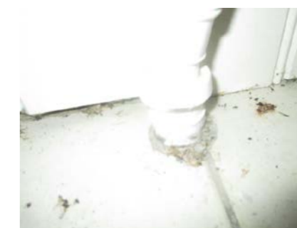
Ingen fuktsikring i overgang gulv og vegg.
