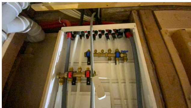
Besiktigelse av røropplegg.
