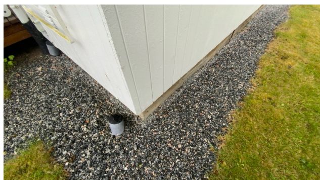
Kontroll av drenering/fuktsikring.
