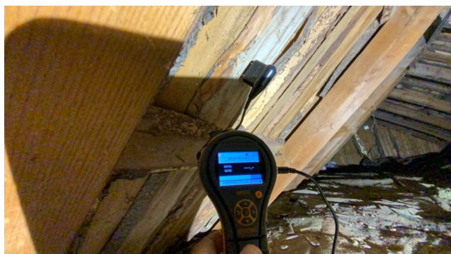
Ingen høy fuktprosent ble målt på undertaket på befaringsdagen for øvrig.
