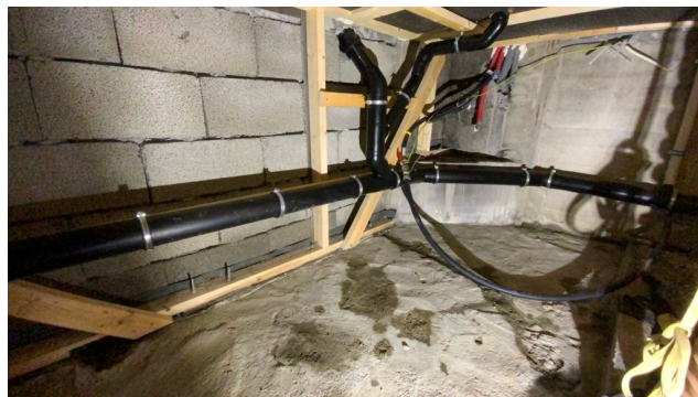
Nye avløpsrør synlig i krypkjeller.
