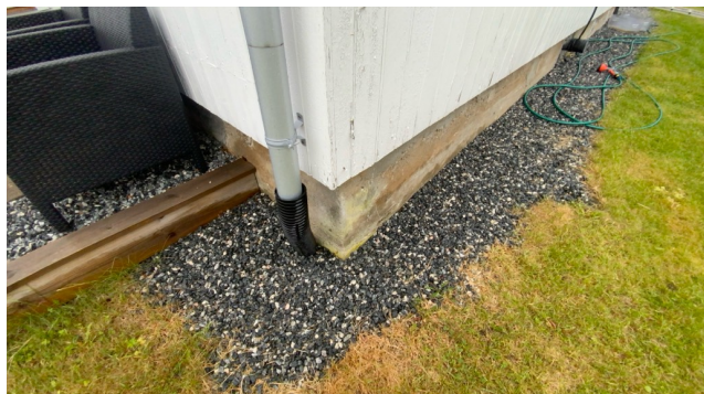
Kontroll av drenering/fuktsikring.
