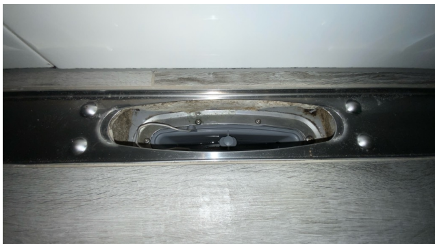
Kontroll av sluk.
