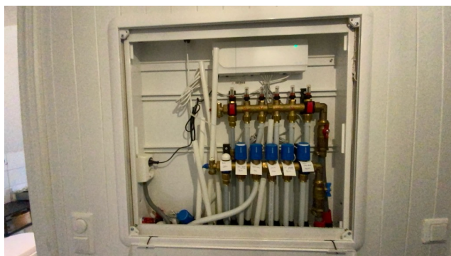
Besiktigelse av røropplegg.
