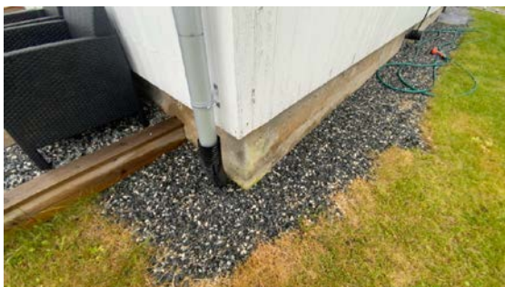
Kontroll av drenering/fuktsikring.
