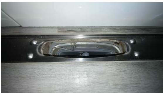
Kontroll av sluk.
