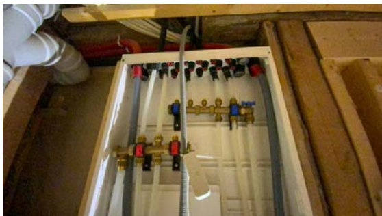
Besiktigelse av røropplegg.
