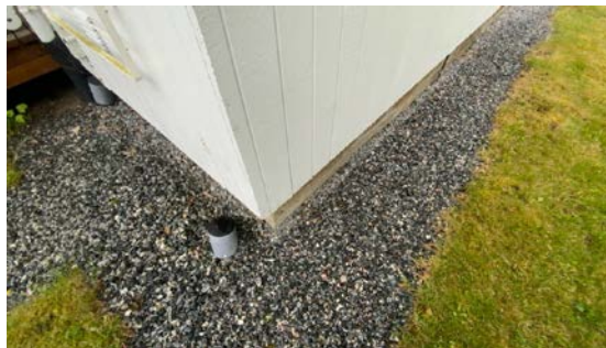
Kontroll av drenering/fuktsikring.
