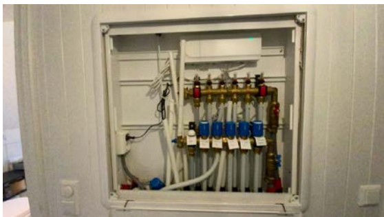
Besiktigelse av røropplegg.
