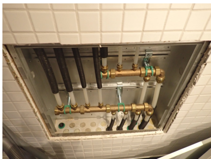
Rørstokk (rør i rør).
