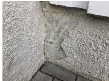
Løst slemming på ringmur på garasje.
