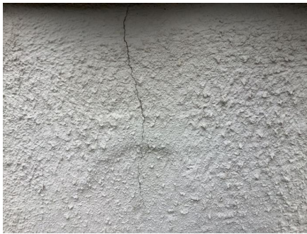
Eksempel på utvendig skråriss.
