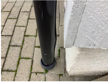
Frostsprengt nedløpsrør.
