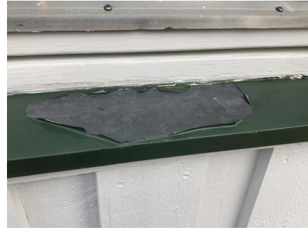
Løstnet maling på vannbrettbeslag.
