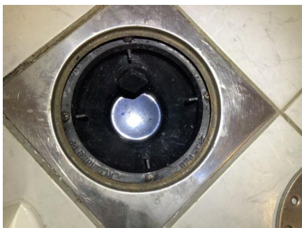
Plastsluk, uten synlig tettesjikt.
