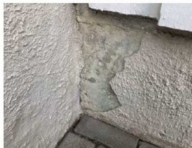
Løst slemming på ringmur på garasje.
