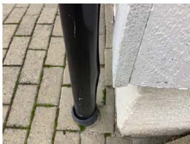
Frostsprengt nedløpsrør.
