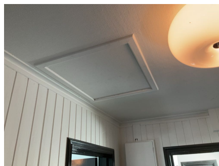
Ingen inspeksjonsmulighet av møneloft på befaringsdagen.
