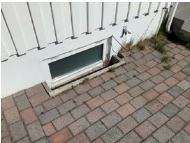
Viktig å følge med på vinduer som ligger helt ned mot terrenget, risiko for vanninntrenging ved snøsmelting og mye nedbør.
