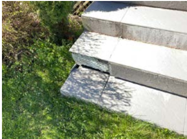
Løs flis på trappen.
