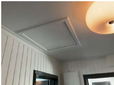
Ingen inspeksjonsmulighet av møneloft på befaringsdagen.
