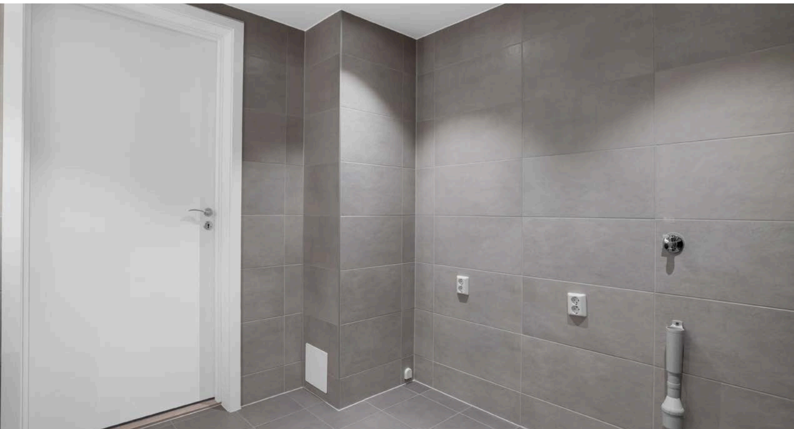
På baderommet er det også plass og opplegg for både vaskemaskin og tørketrommel. Baderommet har flotte fliser på gulv og vegger, deilig gulvvarme, downlights i himlingen og avtrekk via balansert ventilasjon.
