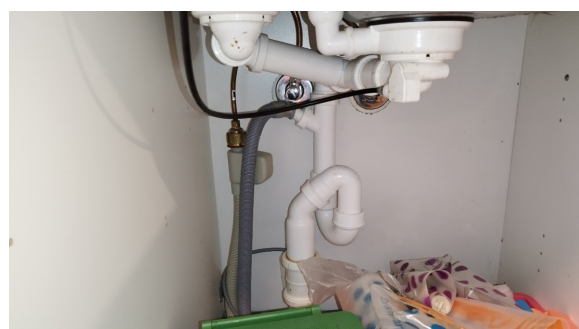
Kontroll av røropplegget.
