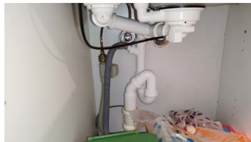
Kontroll av røropplegget.
