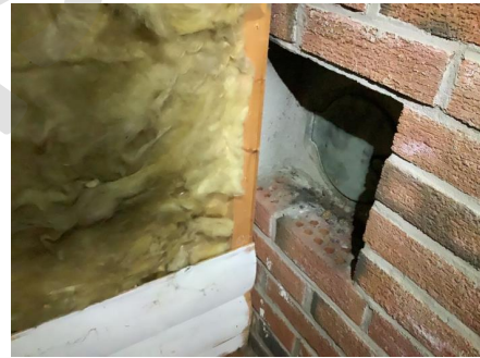
Mindre enn 300 mm avstand fra sotluke til brennbart materiale.
