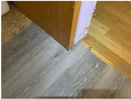
Laminatgulv er lagt imot åpent montert skyvedør.
