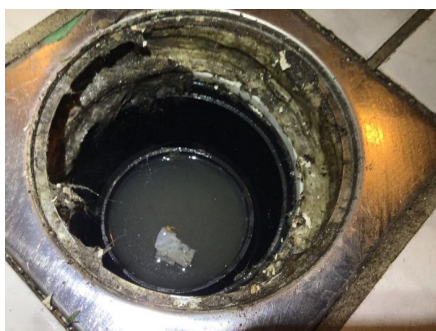
Plastsluk, og det kan se ut til å være noe membranliknende masse rundt sluket.
