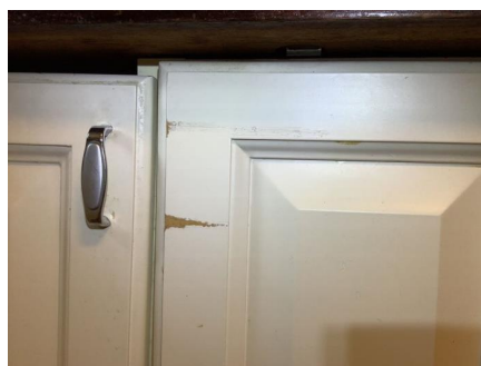
Skade på skapdør, og skjev dør.
