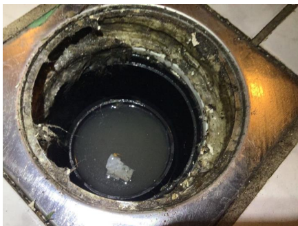
Plastsluk, og det kan se ut til å være noe membranliknende masse rundt sluket.
