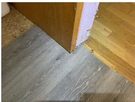
Laminatgulv er lagt imot åpent montert skyvedør.
