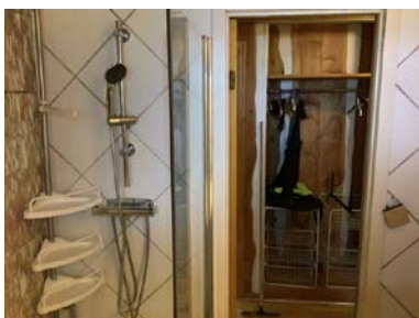
Døren er plassert i den definerte våtsonen.
