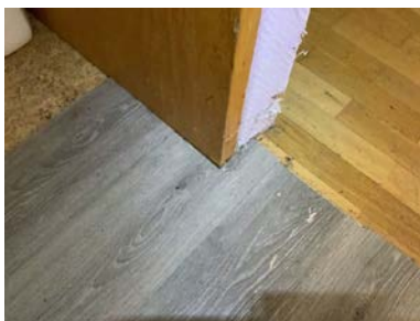
Laminatgulv er lagt imot åpent montert skyvedør.
