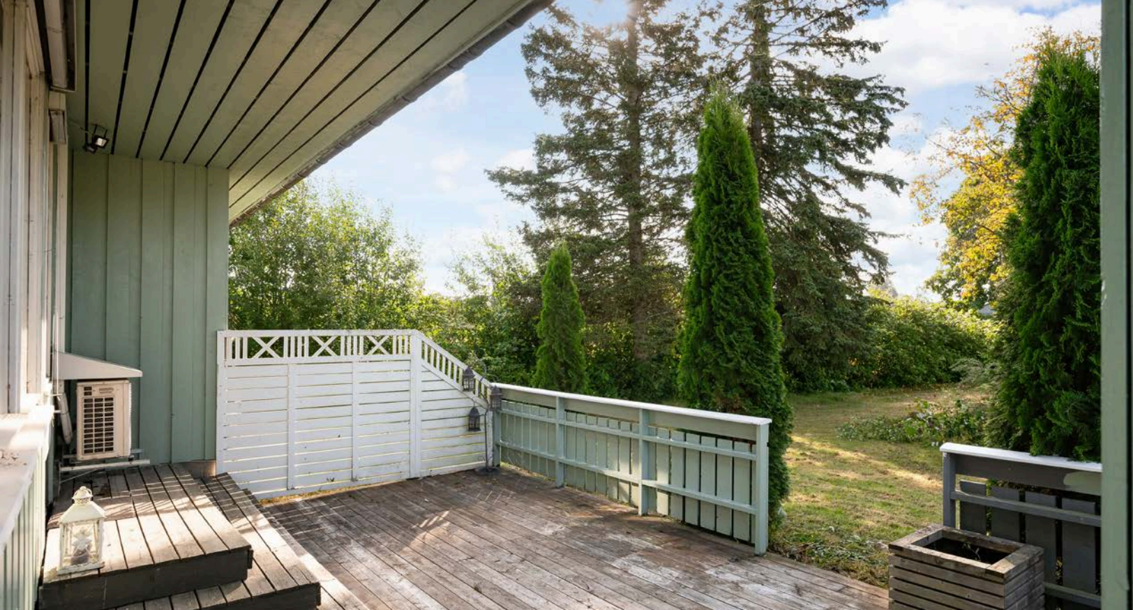
Terrassen er delvis overbygget, har terrassebord på gulv og trapp ned til opparbeidet hage.
