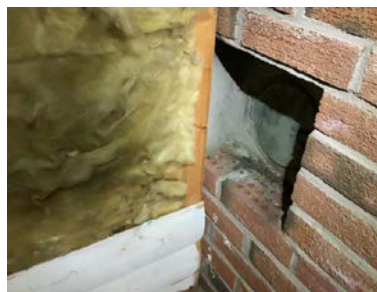
Mindre enn 300 mm avstand fra sotluke til brennbart materiale.
