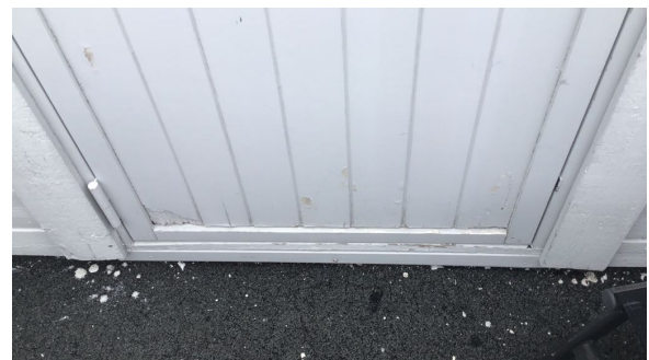
fuktskader/slitasje
