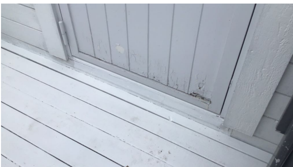
fuktskader/slitasje
