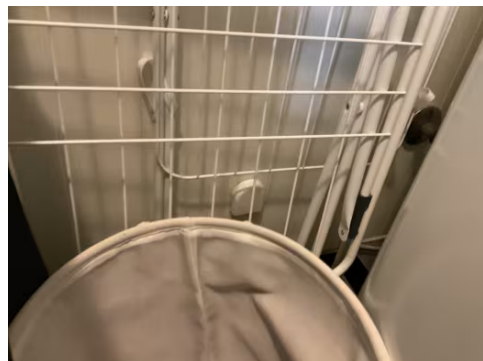
Avrenning fra fordelerskap.
