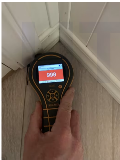
Viser fuktsøk i laminat.
