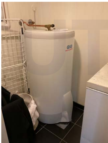
Varmtvannsbereder
