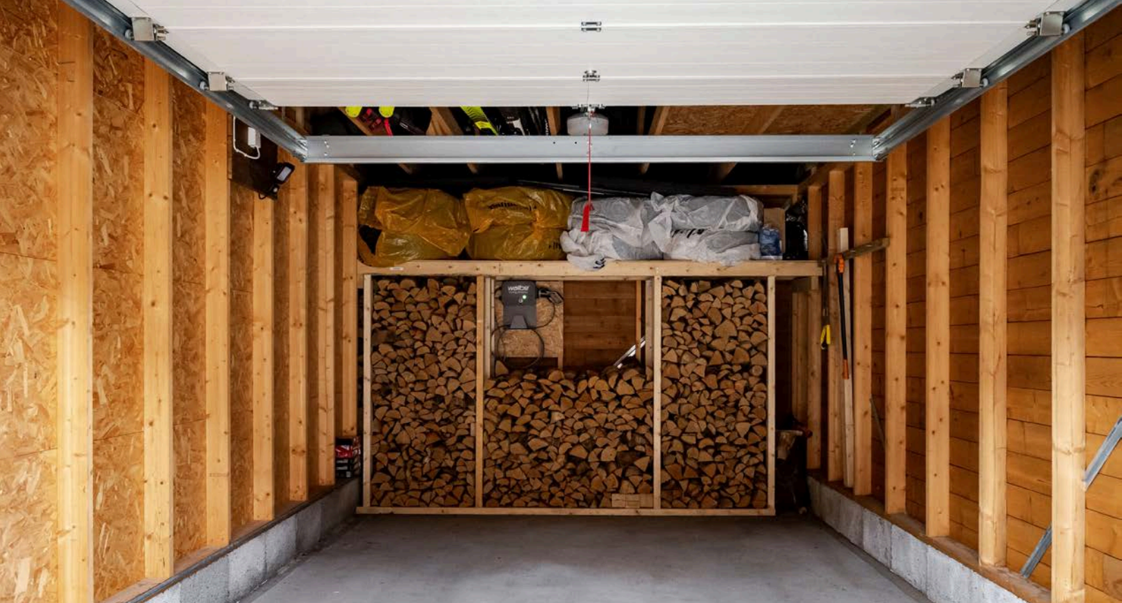
Egen garasje på ca. 18m 2 i felles garasjebygg. Det er montert elektrisk port og elbil-lader.
