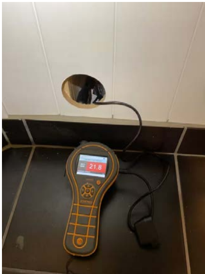
Fuktmåling i tilstøtende rom.
