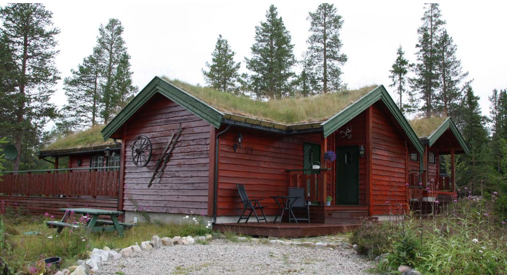
Flott hytte med yttervegger kledd med liggende villmarkspanel. Taket er tekket med torv og ble vedlikeholdt i 2022. (selgers private bilde)
