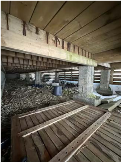
Viser fundamenter til terrasse.
