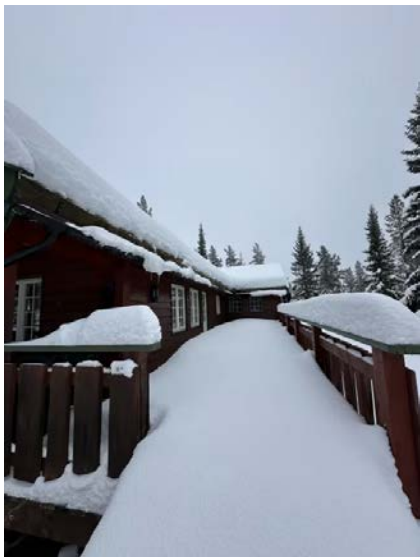
Balkong/terrasse er snødekt og ikke kontrollert.
