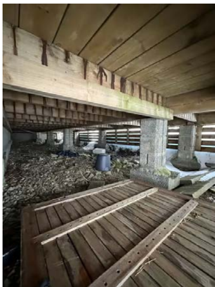
Viser fundamenter til terrasse.
