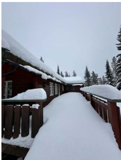
Balkong/terrasse er snødekt og ikke kontrollert.
