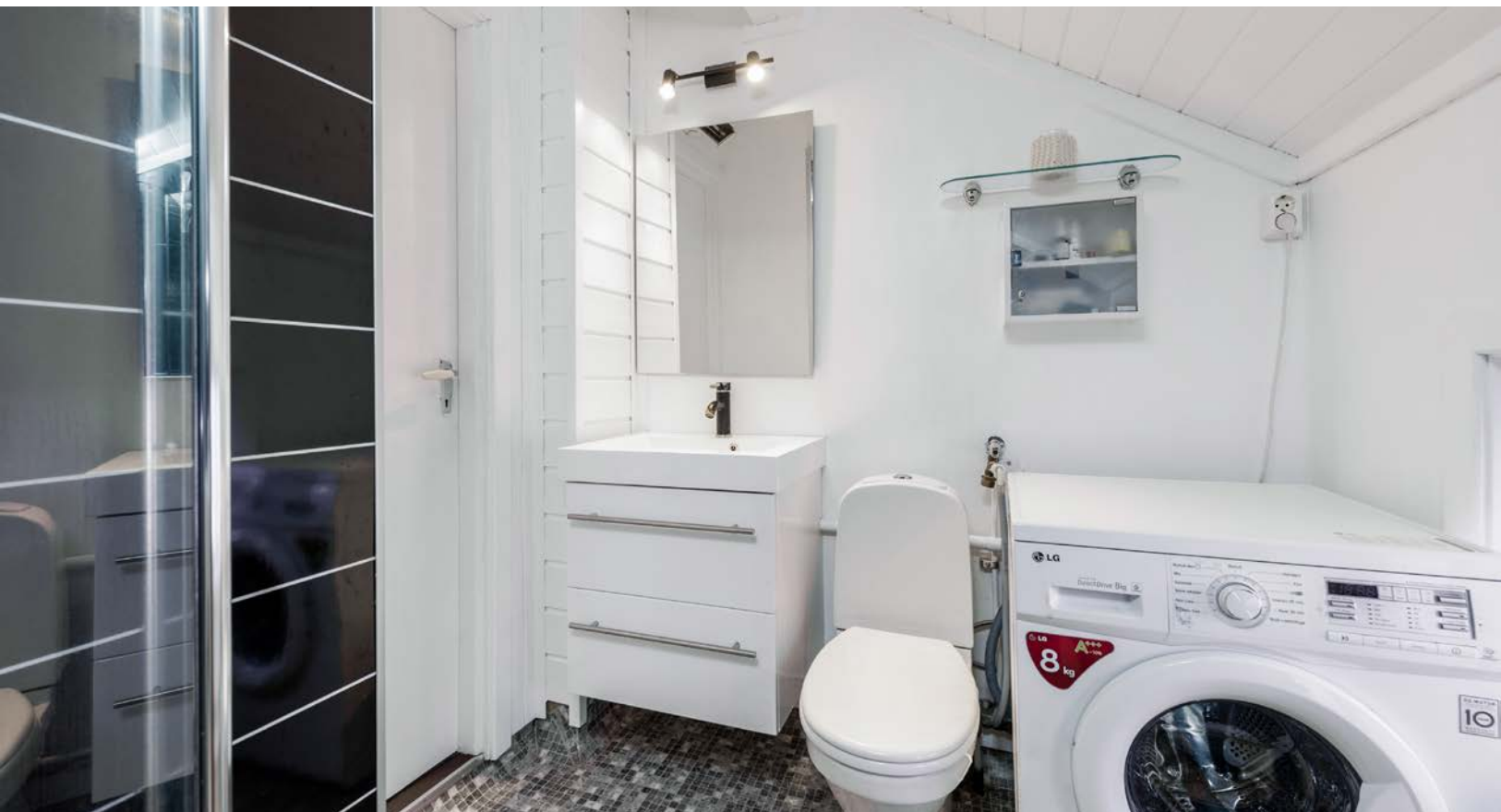
Lyst baderom med våtromsbelegg på gulv, overflater med våtromsplater, malt panel og malte plater, samt elektrisk styrt vifte.
