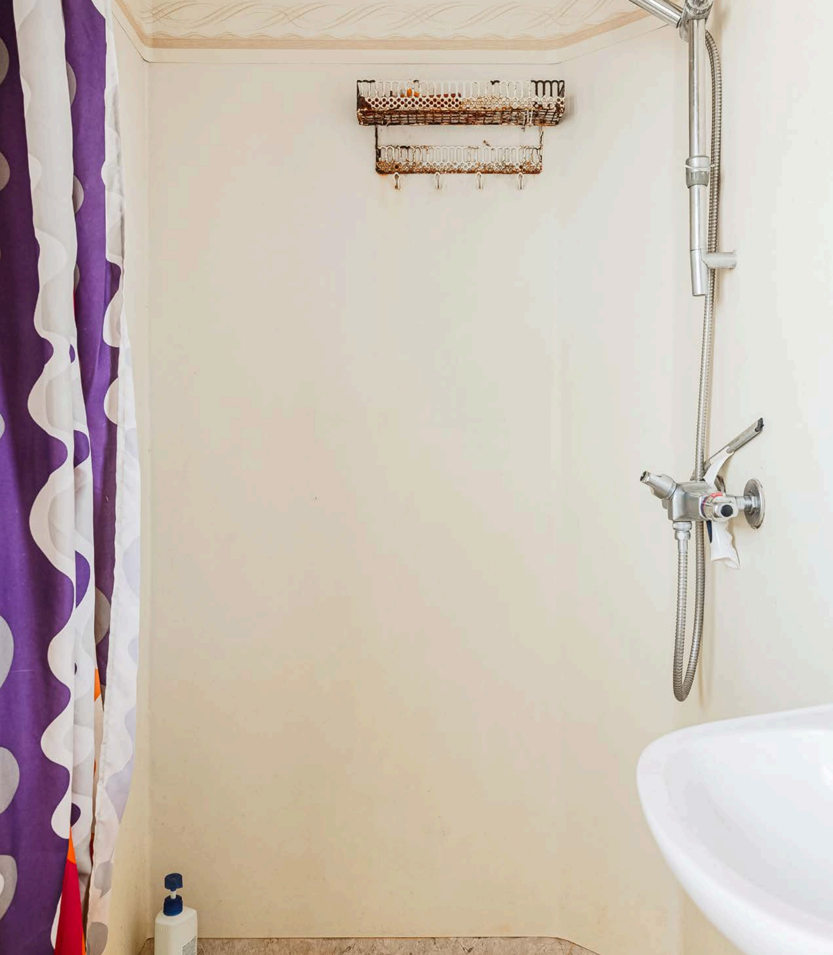
Eldre baderom i 2. etasje med våtromsbelegg på gulv og vinylbelegg på veggene.
