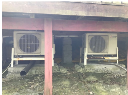
Varmepumpe ytterdeler.
