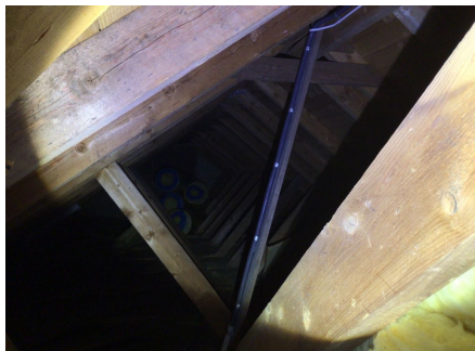
Del av konstruksjon sett fra loft.
