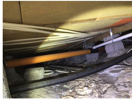
Del av avløp til vann, under hytten.
