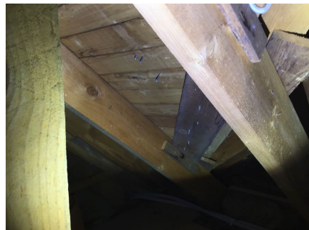
Del av konstruksjon sett fra loft.
