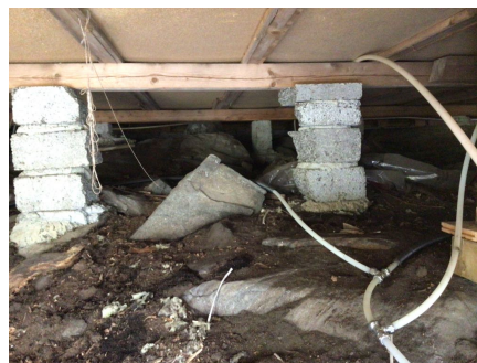
Eksempel på pilarer under hytte.
