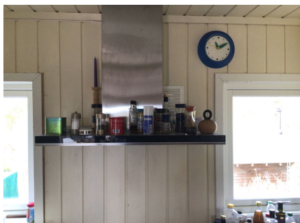
Montert avtrekk over gass komfyr.
