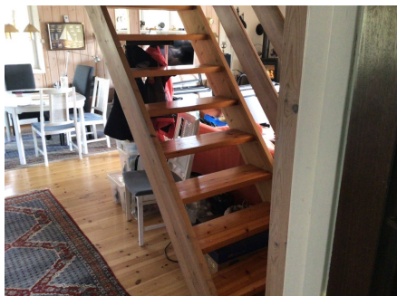
Trapp fra 1 etasje og opp til 2 etasje.
