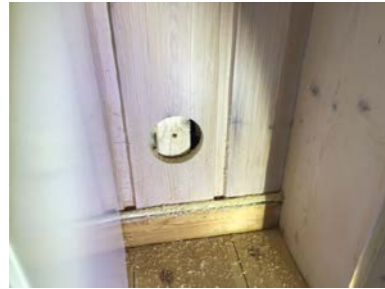
Hull for kontroll av fukt.
