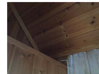
Del av vegg - tak.
