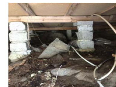
Eksempel på pilarer under hytte.
