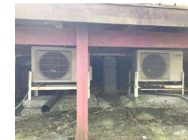
Varmepumpe ytterdel.
