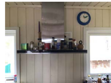
Montert avtrekk over gass komfyr.
