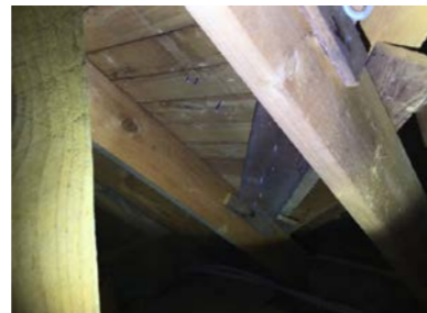
Del av konstruksjon sett fra loft.
