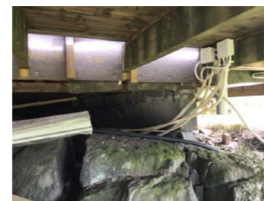
Del av grunnmur under hytte.
