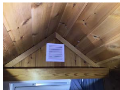
Eksempel på montert ventil i vegg.
