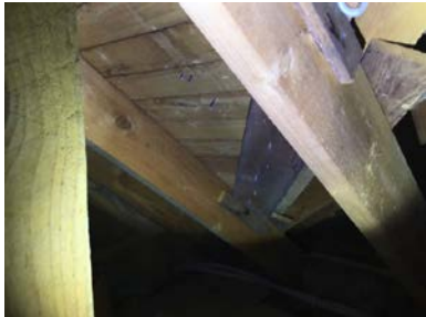
Del av konstruksjon sett fra loft.
