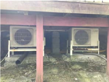
Varmepumpe ytterdeler.
