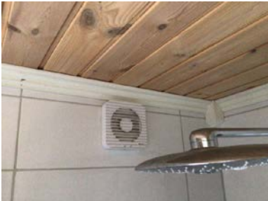
Montert avtrekk i vegg.
