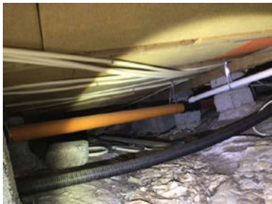
Del av avløp til vann, under hytten.
