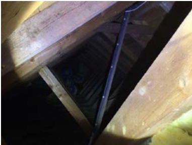
Del av konstruksjon sett fra loft.
