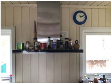
Montert avtrekk over gass komfyr.
