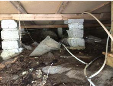
Eksempel på pilarer under hytte.
