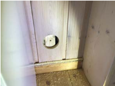
Hull for kontroll av fukt.
