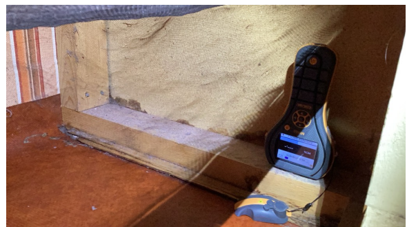
Ved fuktmåling ble det registrert tørre verdier.
