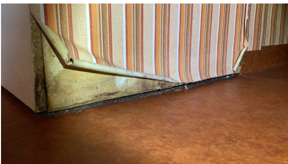
Fuktskader.
