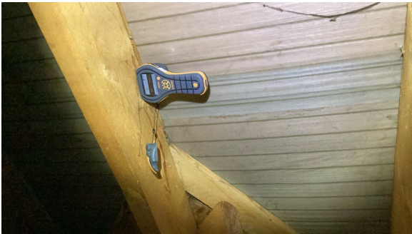
Ved enkel fuktmåling registrerte jeg tørre verdier.
