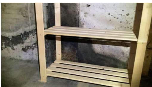
Misfarging på vegg.
