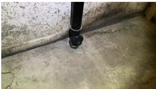
Stakeluke i kjeller.
