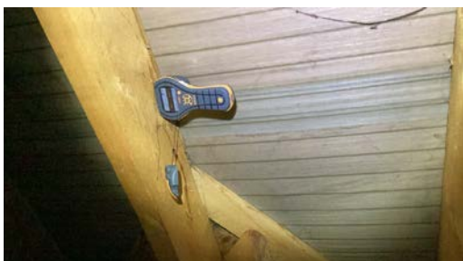
Ved enkel fuktmåling registrerte jeg tørre verdier.
