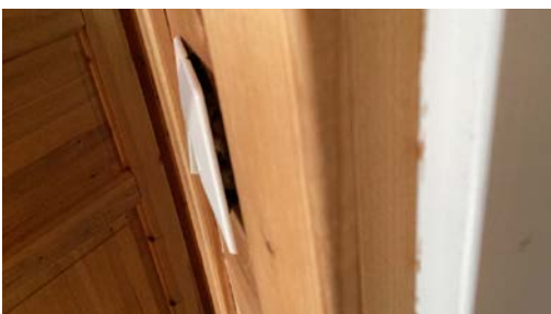
Bryterdeksel glipper fra vegg.
