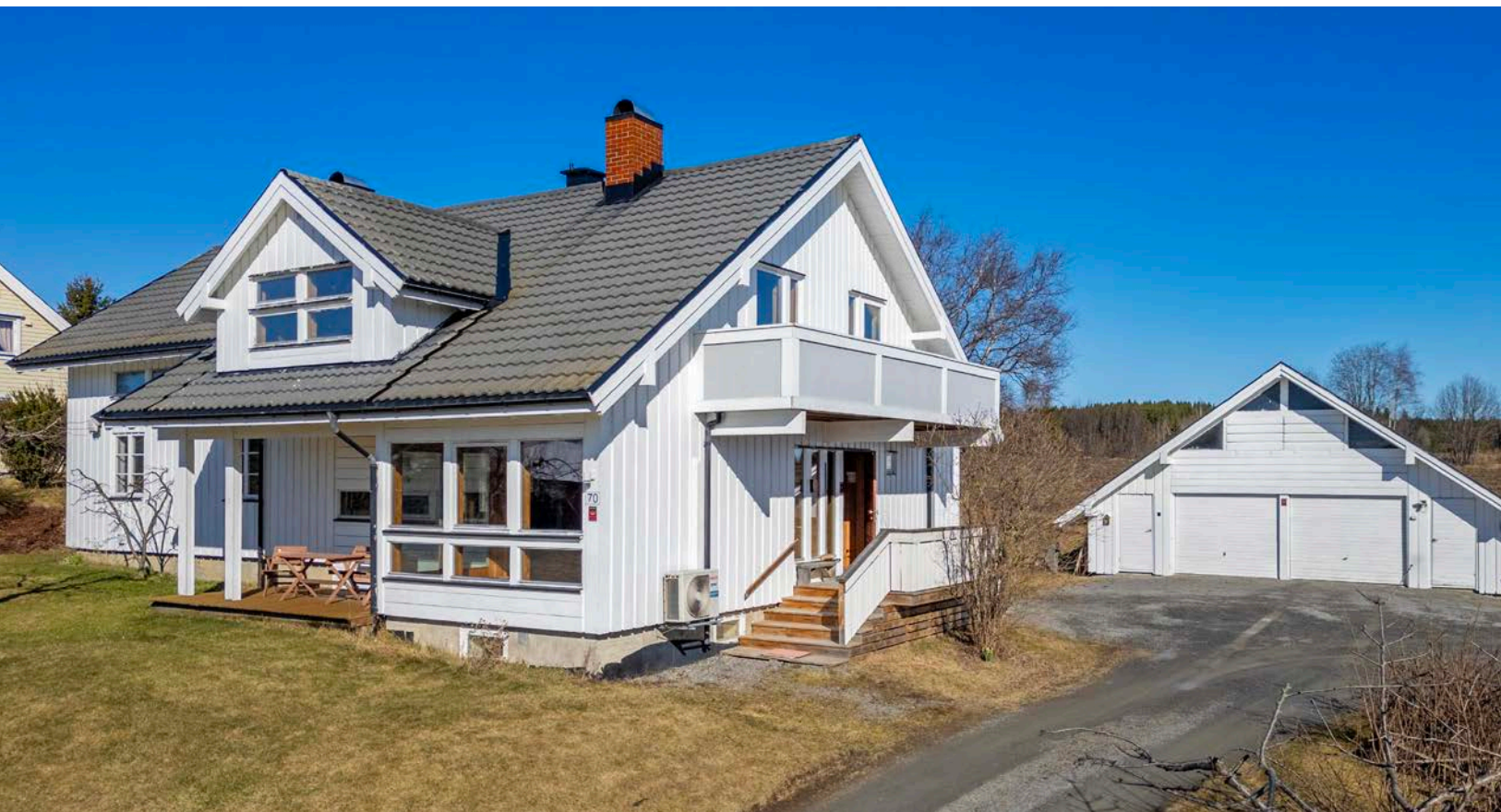
Dobbelgarasje på eiendommen.
