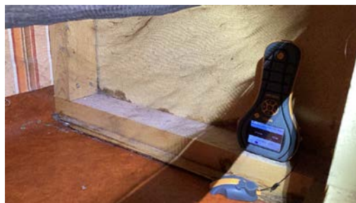
Ved fuktmåling ble det registrert tørre verdier.
