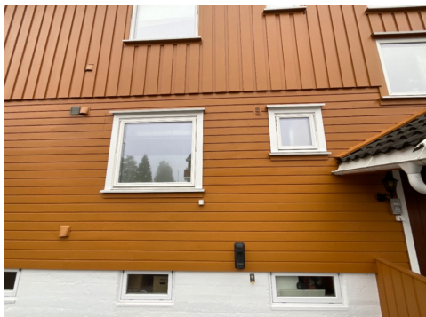
Kjøkken og baderomsvindu
