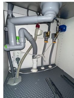
Rørproplegg i kjøkkenbenk med Waterguard
