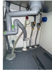
Røropplegg i kjøkkenbenk med Waterguard
