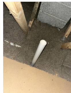
Rør for utluft sentralstøvsuger må føres ut av takkonstruksjonen.
