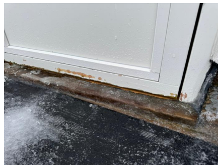
Utvendig løøsning i nedkant av dør.
