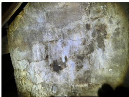
Spekker i pipen på kaldloftet.
