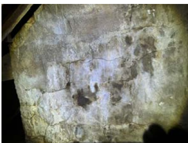
Spekker i pipen på kaldloftet.
