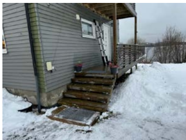
Manglende rekkverk.
