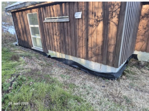
Bildet viser grunnmursplast som ikke er ferdigstilt.
