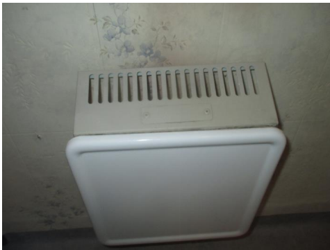
Panelovn på veggen.
