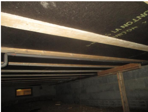
Deler av krypkjeller.
