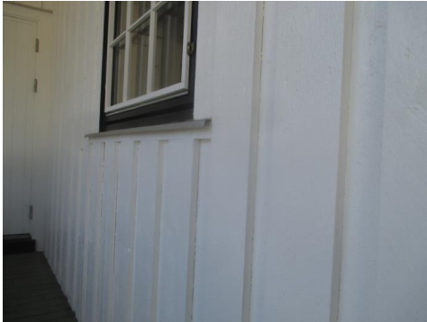
Deler av kledningen med tilhørende belistninger.
