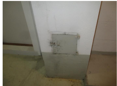
Sotluke i kjeller.
