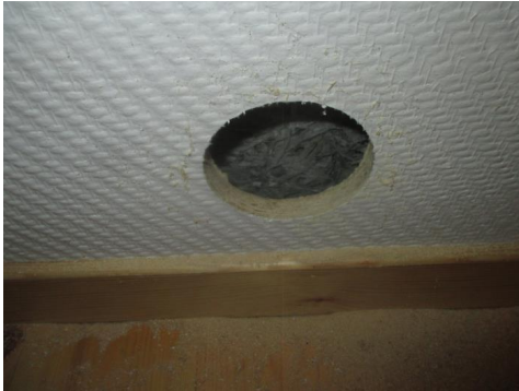
Hulltaking i utfored vegg i kjellerstue.
