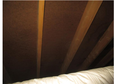
Sutakplater som undertak på tilbygget del
