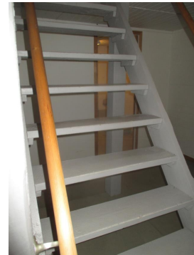
Enkel plassbygget trapp til kjeller.
