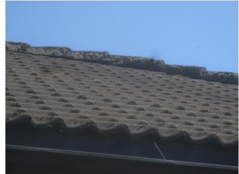
Deler av taktekkingen
