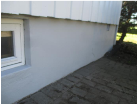
Deler av støpt grunnmur.
