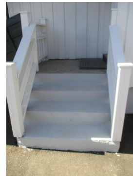
Støpt trapp ved bad/vaskerom.
