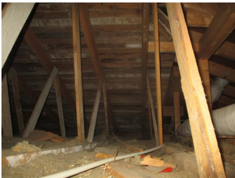
Plassbygget takstoler til en valmet takkonstruksjon.
